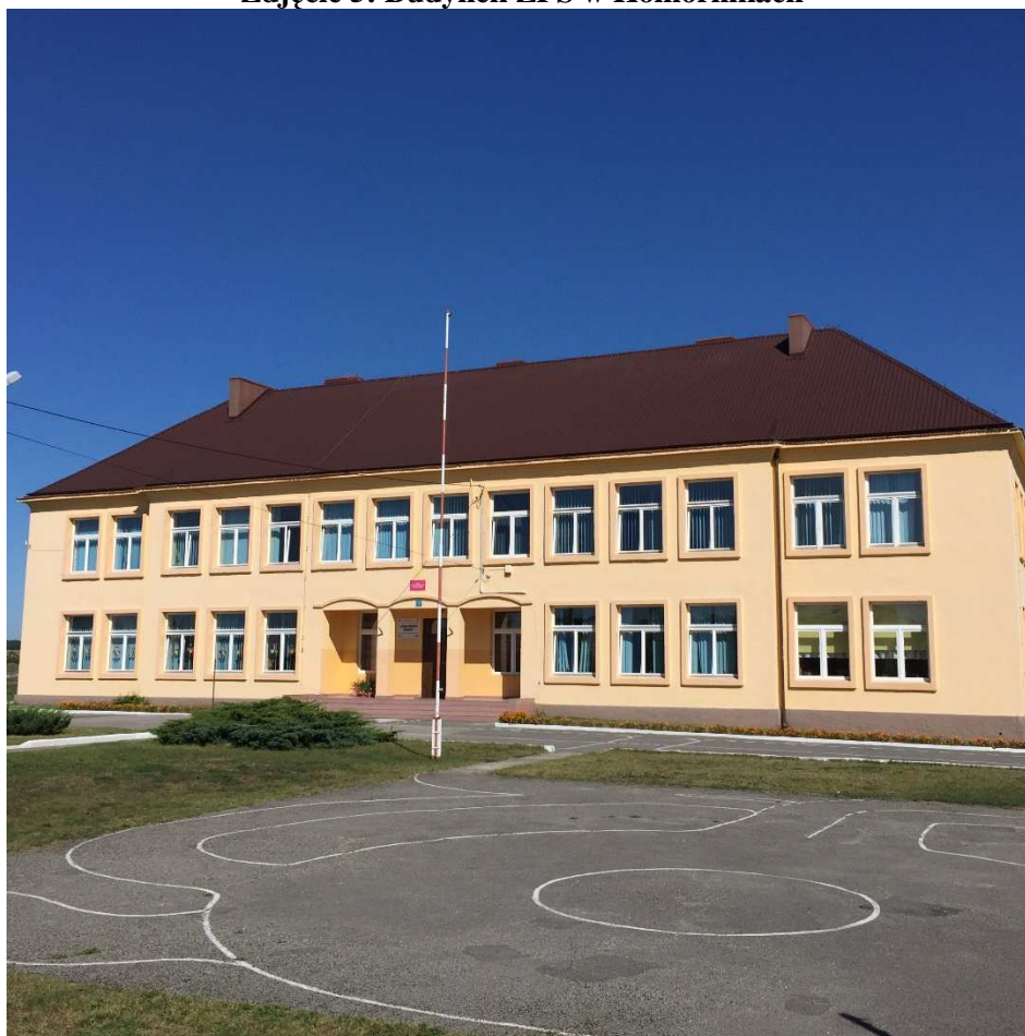
Zdjęcie 5: Budynek ZPS w Komornikach
