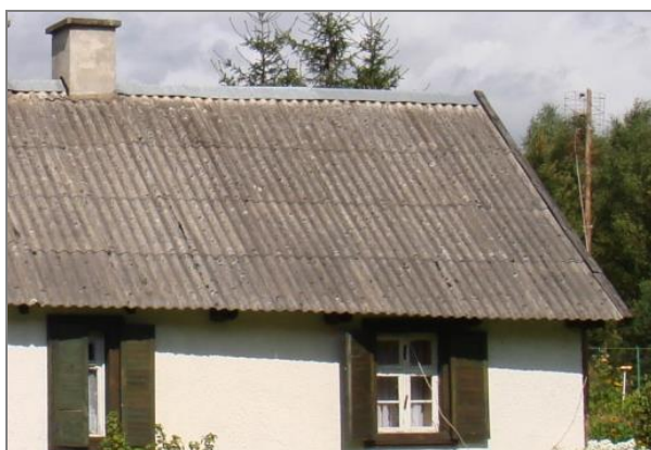
Fot.1 Płyty azbestowo-cementowe faliste
